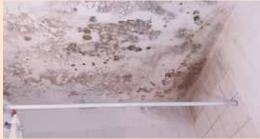
Plafond de la salle de bain.
